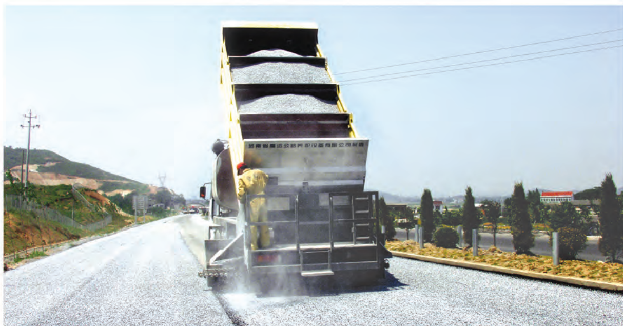
橡胶沥青同步碎石封层施工现场
