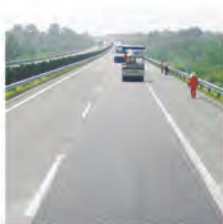
36 / 灌注式水泥—沥青混合料 ( PCA ) 技术 GROUTING CEMENT-ASPHALT MIXTURE ( PCA )
