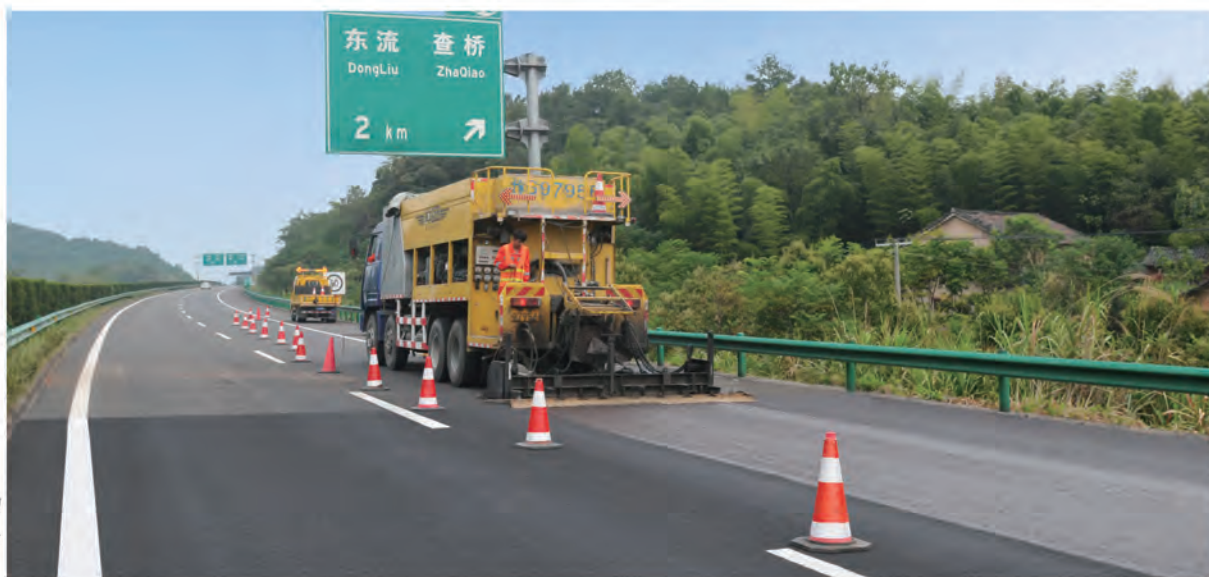
MOH材料处理 桥头跳车技术 施工现场
