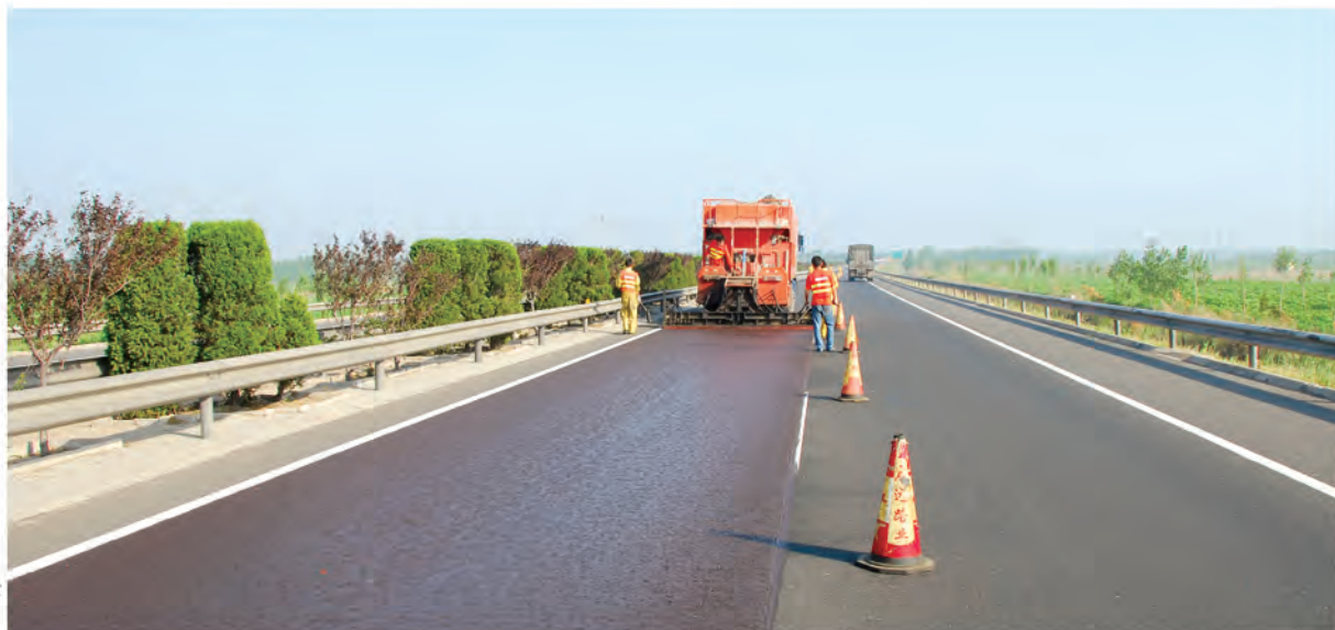
低噪声微表处技术 施工现场
