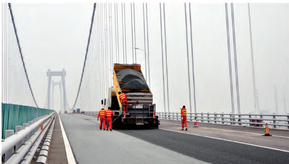
精细抗滑保护层 技术施工现场
