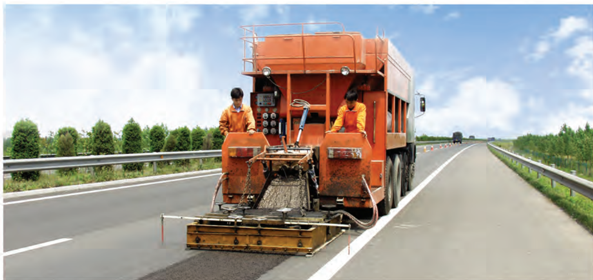
微表处修复车辙 技术施工现场
