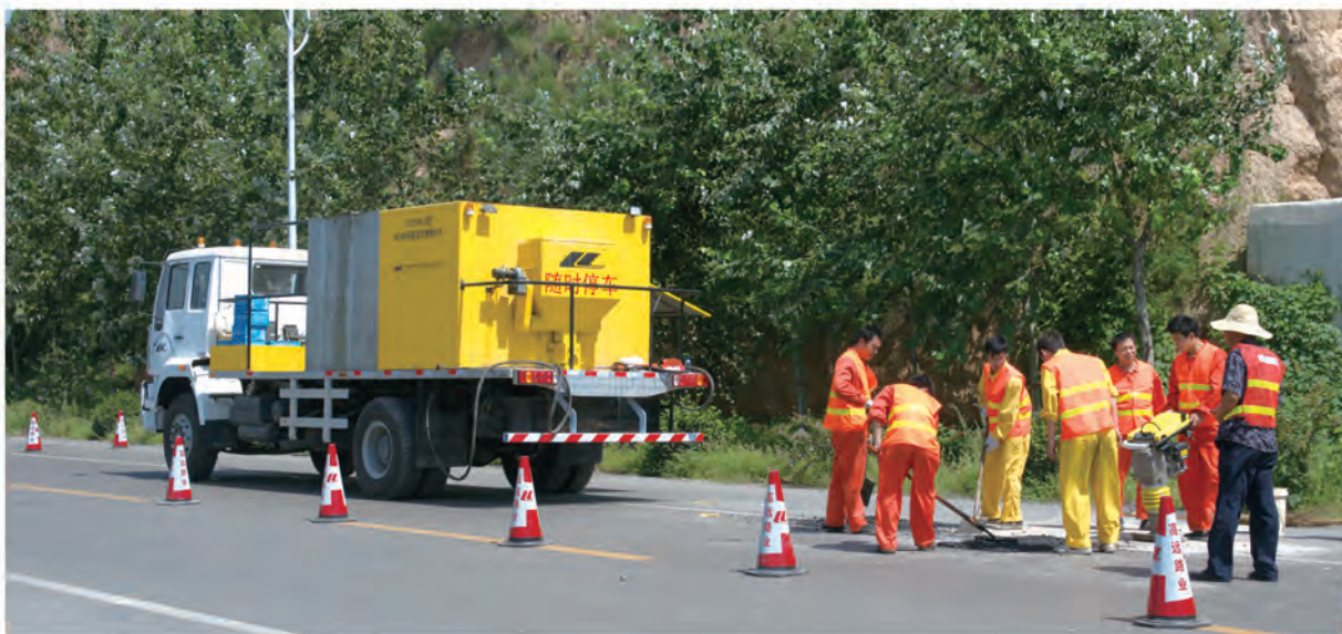
MOH材料路面 坑槽修补技术施 工现场
