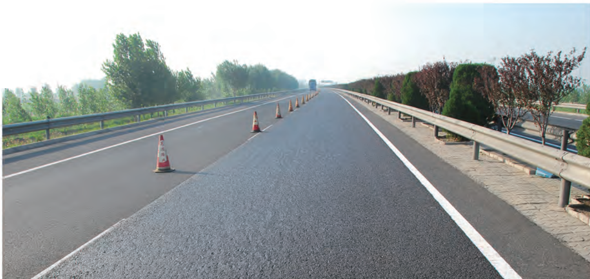
纤维微表处技术 在施工中的应用
