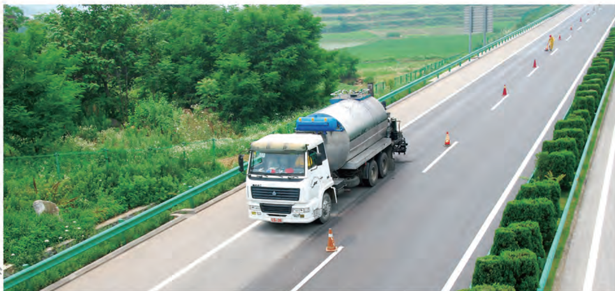
雾封层技术 施工现场
