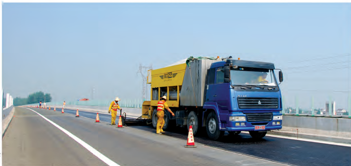
复式微表处技术 施工现场
