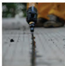
34 / 路面灌缝技术 ROAD CRACK FILLING
