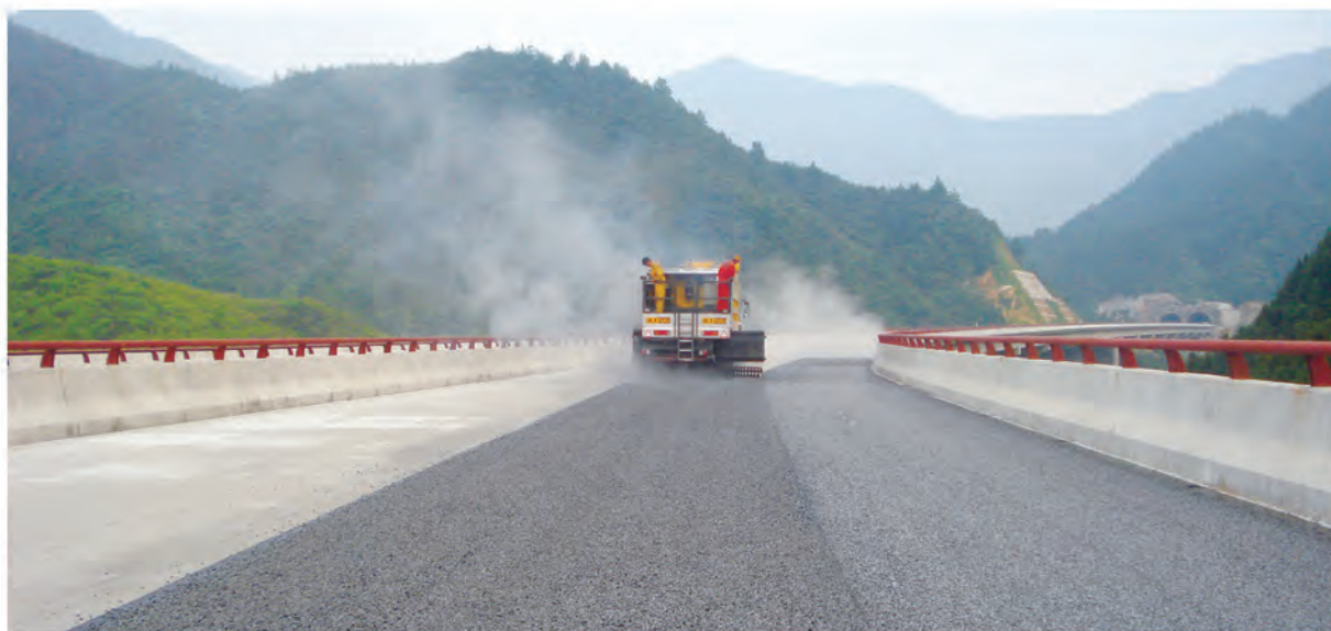
水泥混凝土桥面 防水粘结层技术 施工现场
