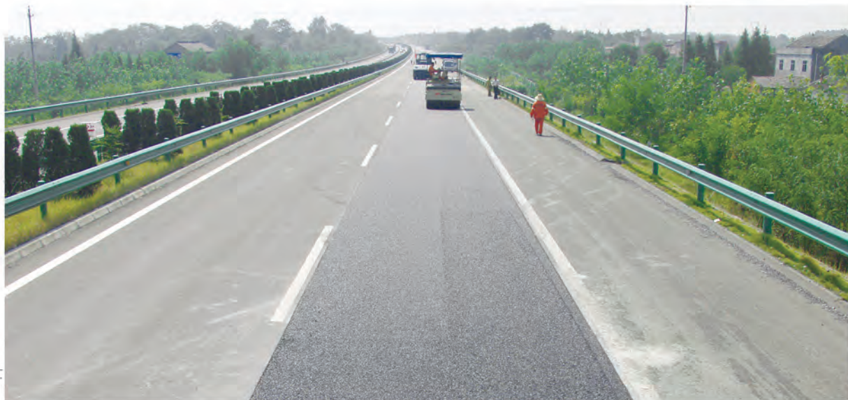
PCA技术施工现场
