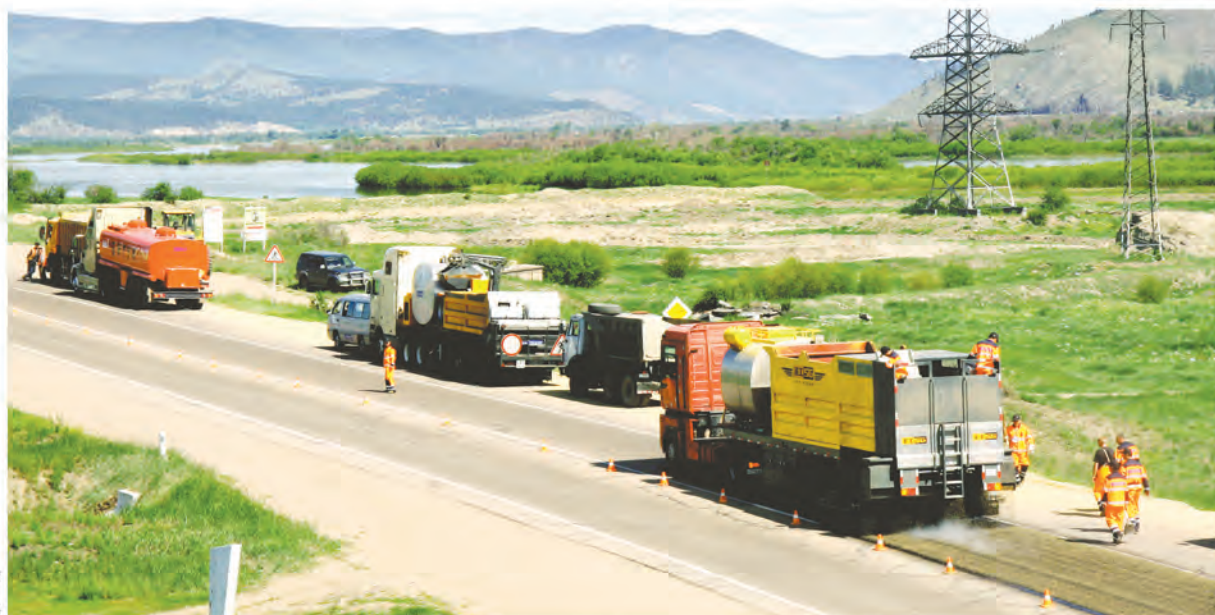
纤维碎石封层 技术施工现场
