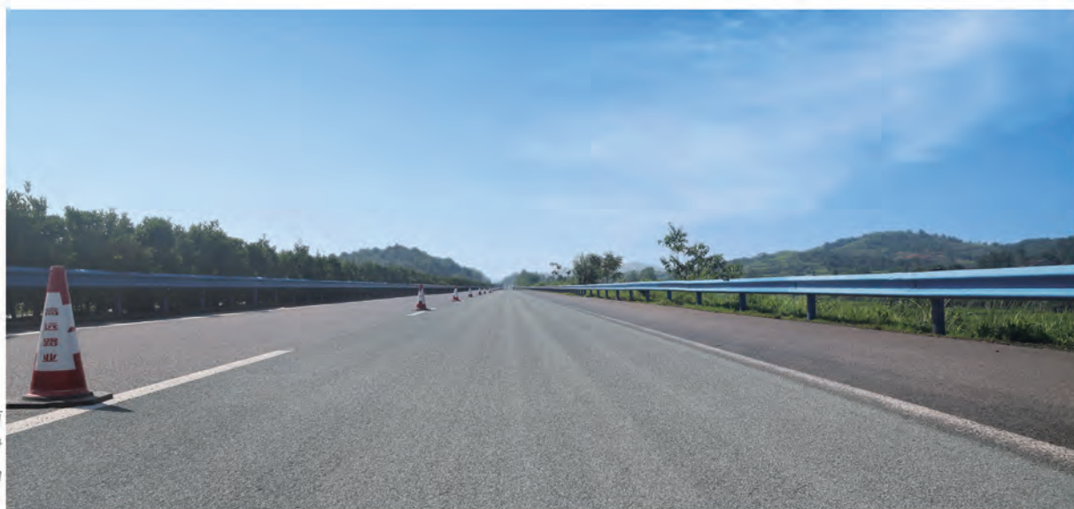
沥青混凝土路面 KF-1型抗滑雾封 层技术在施工中的 应用
