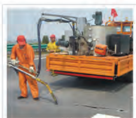
开槽灌缝施工
