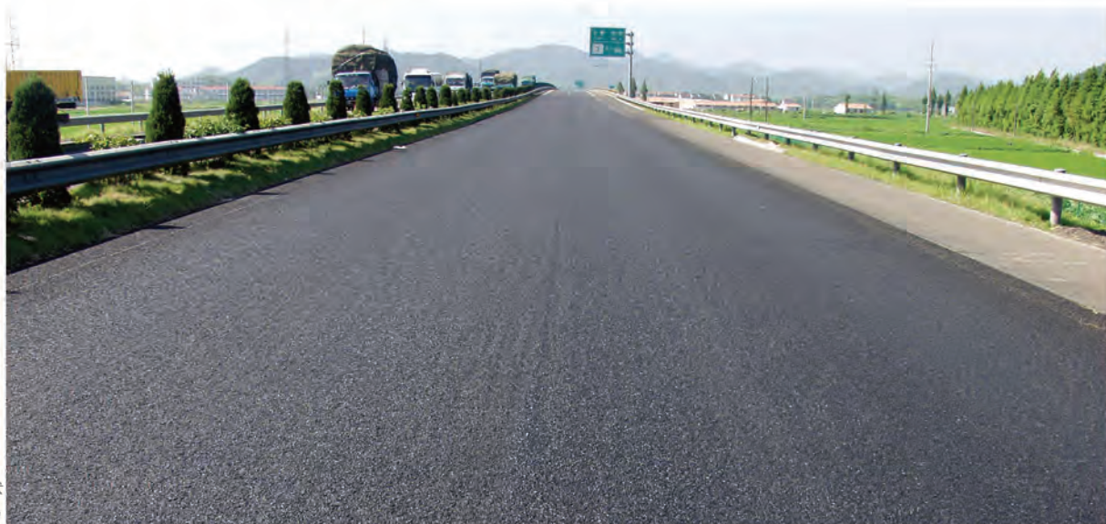
微表处罩面技术 在施工中的应用
